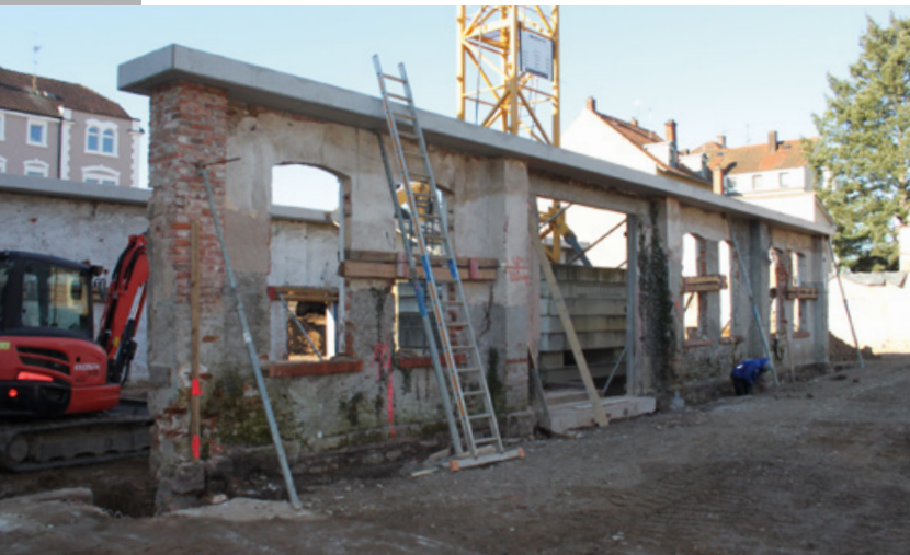
Vorsichtig abstützen: Die Außenwände der historischen Fabrikhalle bleiben erhalten und schmücken den zukünftigen Innenhof.
