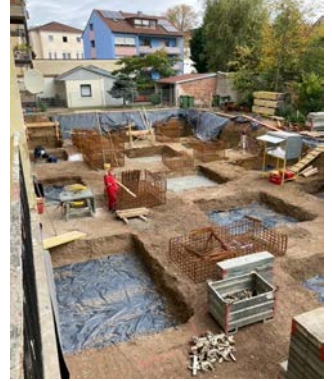
Sieht wüst aus, dient jedoch der Bequemlichkeit: Der Schacht für den neuen Aufzug ist bereits gut erkennbar.
