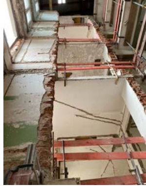
Sieht wüst aus, dient jedoch der Bequemlichkeit: Der Schacht für den neuen Aufzug ist bereits gut erkennbar.
