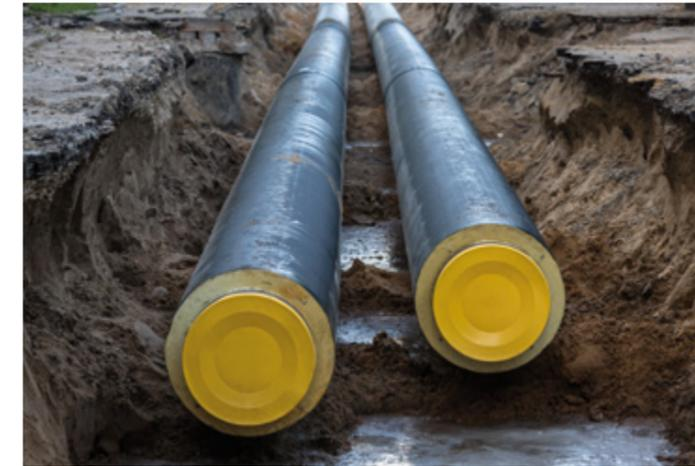
Abb. oben: Fernwärmerohre auf dem Gelände der Offenburger Kronenwiese – ebenfalls durch unsere Initiative
