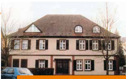
Sanierung eines denkmalgeschützten Hauses in Lahr, Kaiserstraße
