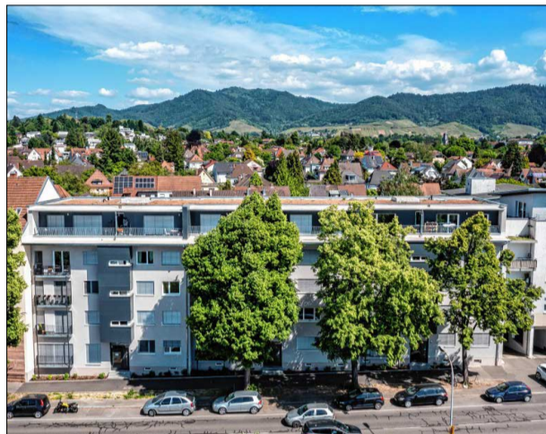
Die attraktive Modernisierung der Moltkestraße 13, 15 und 17 in Offenburg macht die Mehrfamilienhäuser zukunftsfähig.
